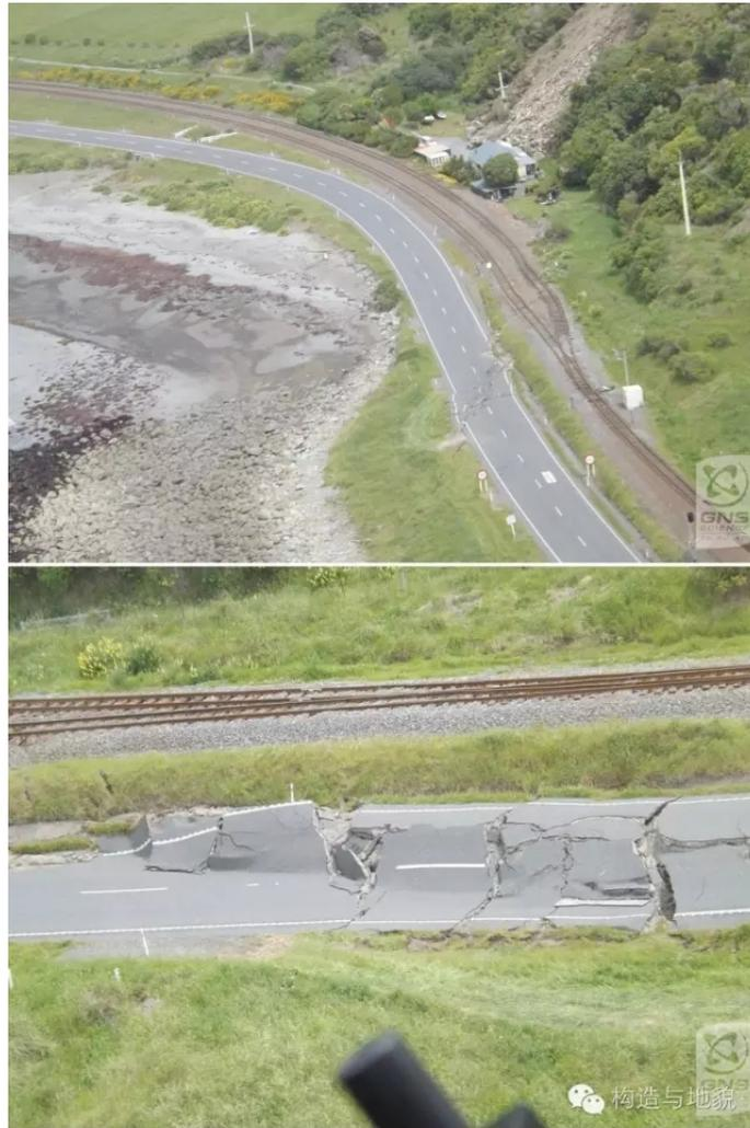
图 10. HundaLee 断层尖部上地震造成的地表破裂. (来源: GNS)
