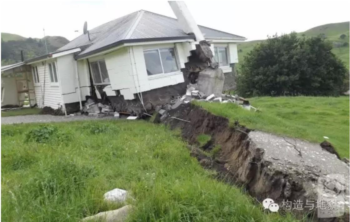
图 9. Kekerengu 断层破裂早曾的房屋损坏. (来源: GNS)
